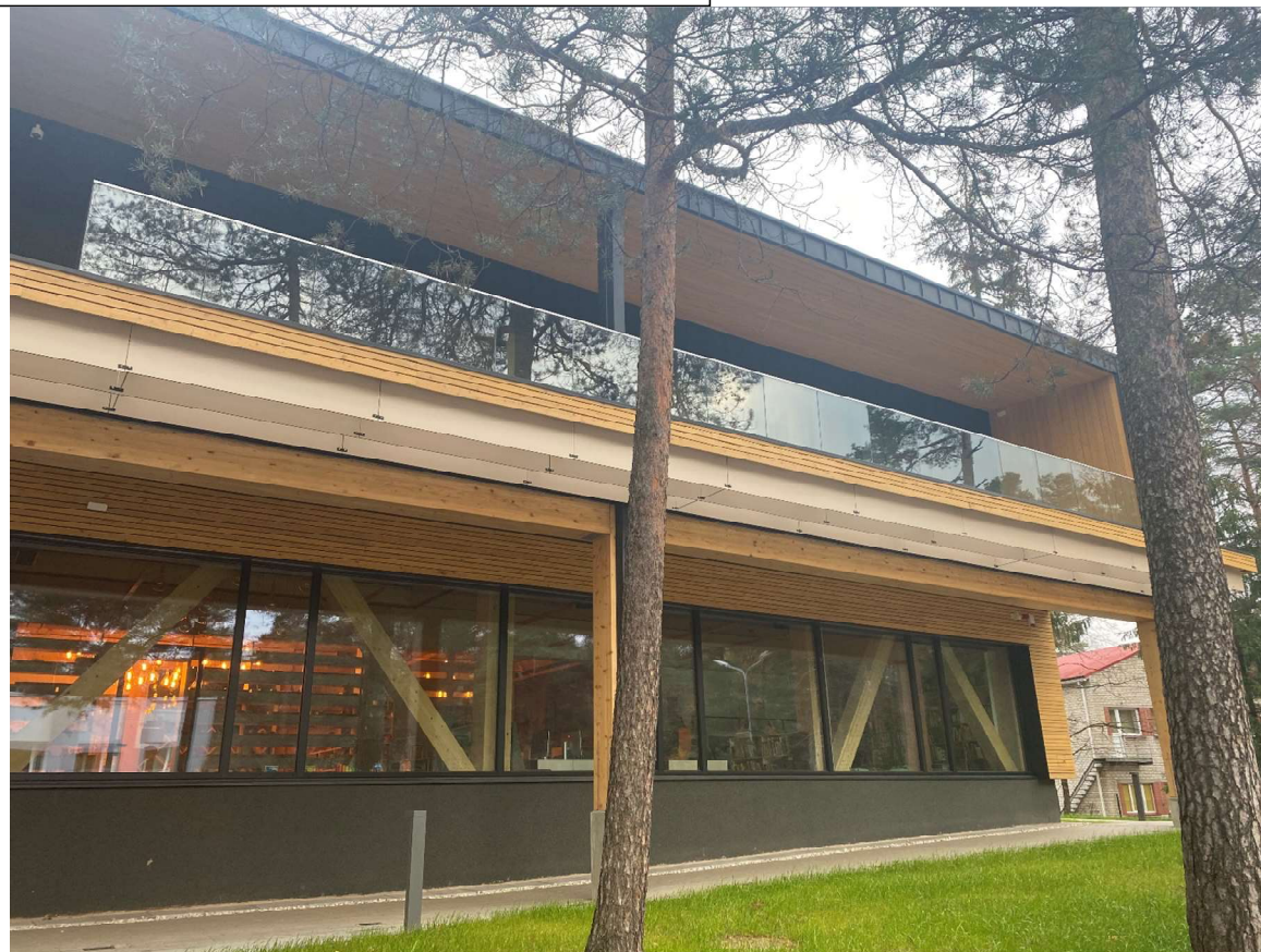
1. UN 2.STĀVA PĀRSEGUMU PĀRKĀRE DIENVIDU PUSĒ
