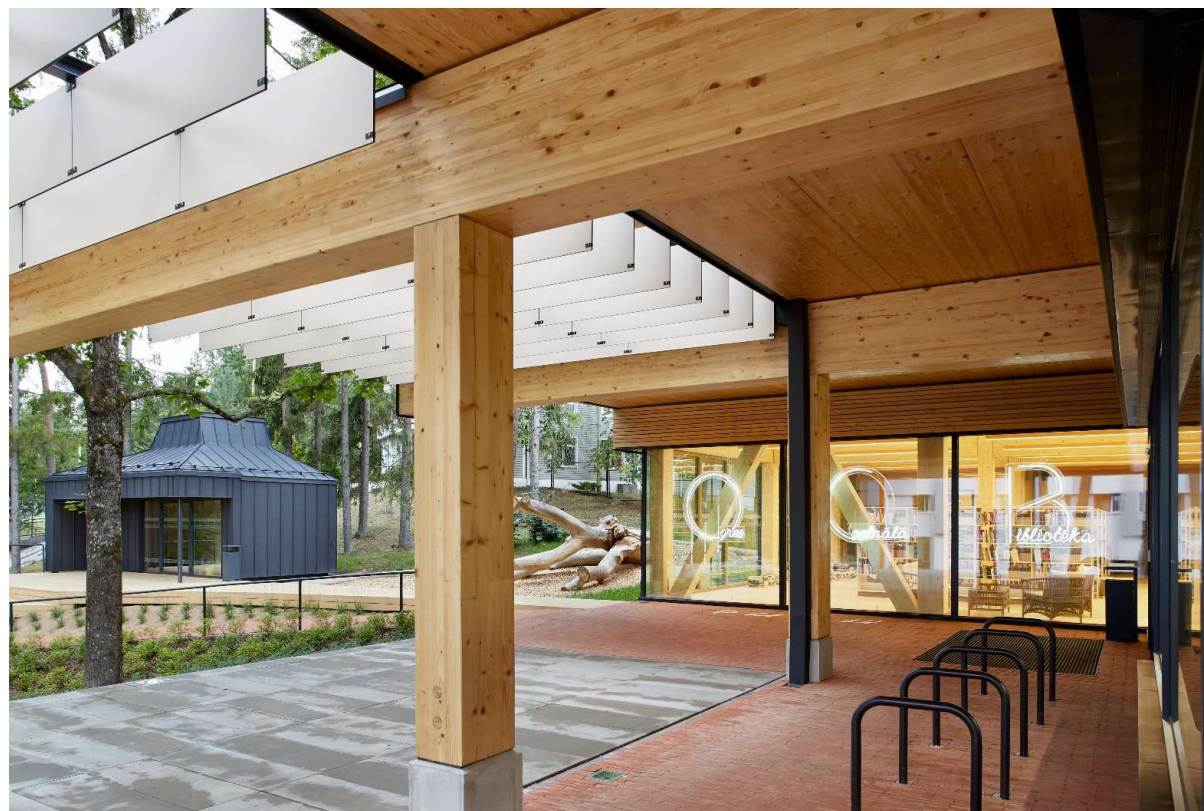
KOKA NESOŠĀS KONSTRUKCIJAS
